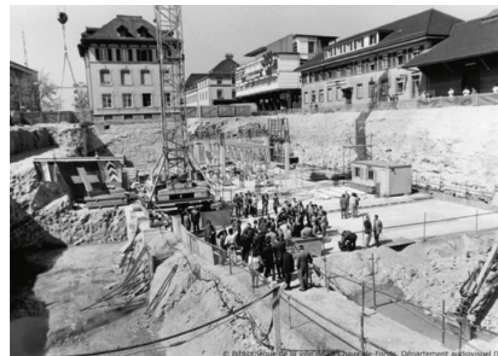
La pose de la première pierre en 1994. Au fond, le bâtiment qui sera démolé plus tard pour laisser place à la tour. DAV (FONDS L'EXPRESS)
