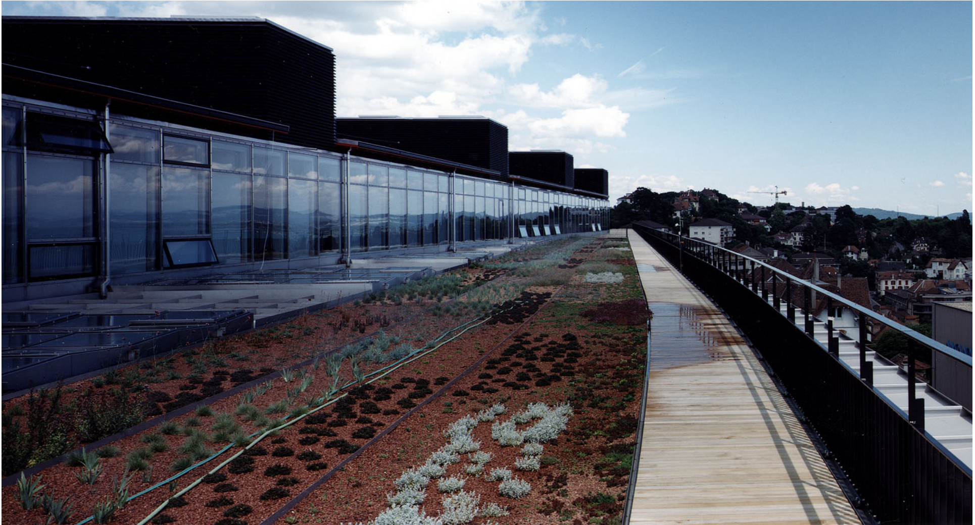
Vue de la toiture végétalisée OFS 1 (photo R. Walti)
