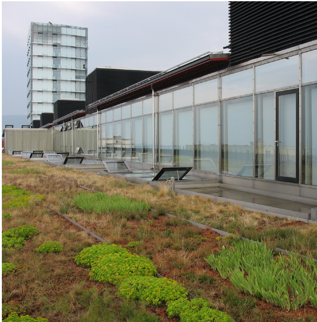
Récupération des eaux pluviales OFS
