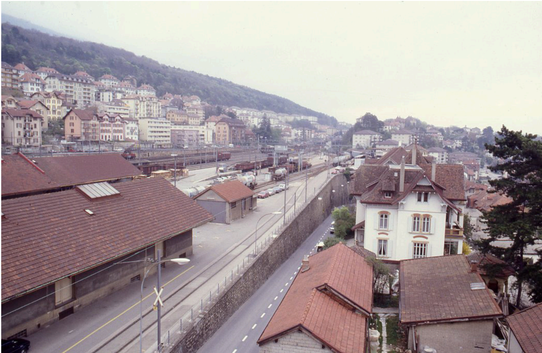
Vue du site avant les travaux (document Bauart)
