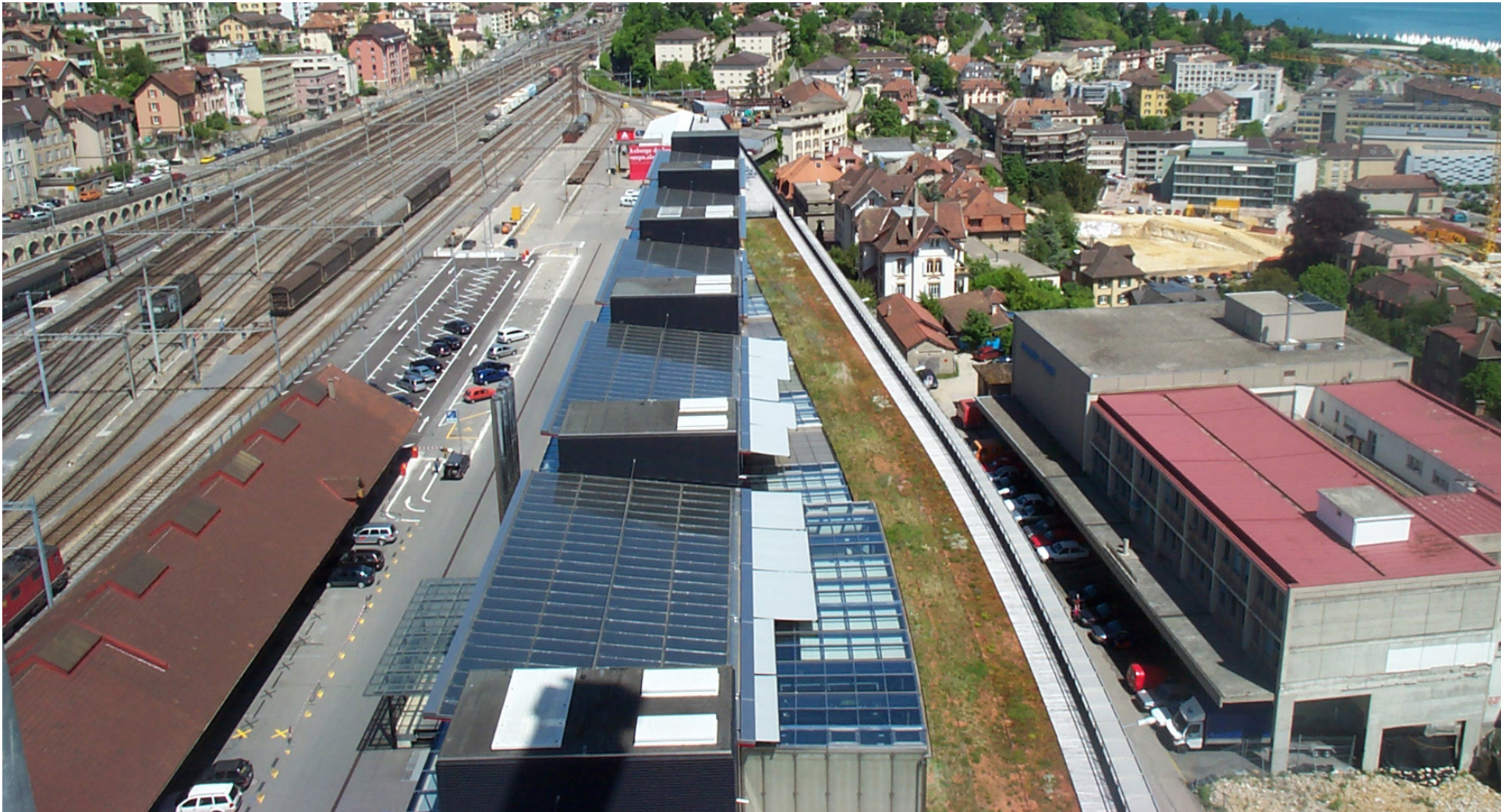
Energie solaire : Toiture solaire du bâtiment principal (photo Bauart)
